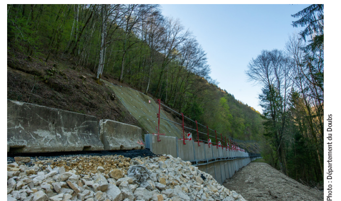
Travaux RD 492 - Amancey à Nans-sous-Sainte-Anne
