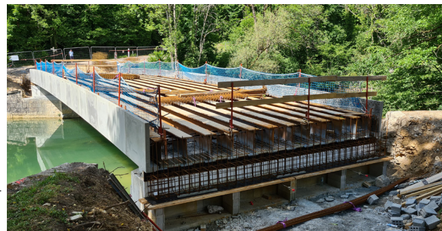
Travaux sur le Pont des Pipes
