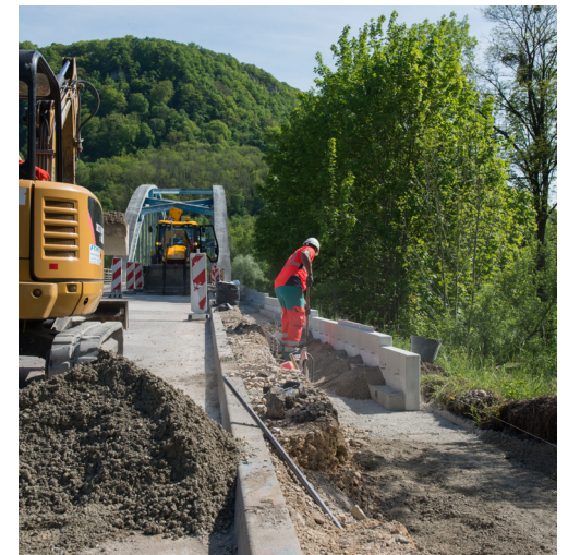
Chantier routier RD 50
