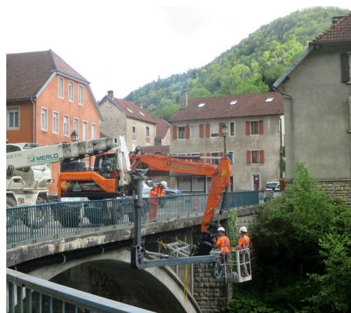
Les travaux d'interconnexion pour l'eau potable Saint-Hippolyte-Valoreille
