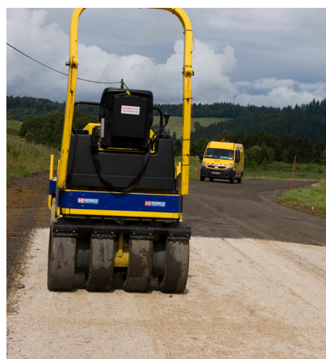
Chantier routier sur D46 Les Pontets
