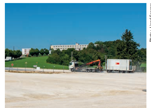
Travaux en cours sur le site du futur collège de Bethoncourt
